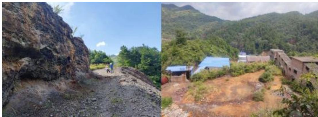
图 3-1 项目废渣堆现状
